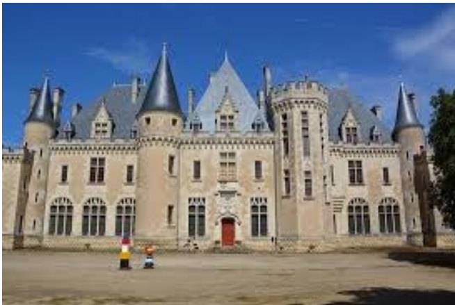
Château de Montaigne ( Saint Michel de Montaigne )
